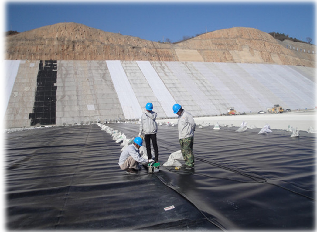
Installing the geomembrane
